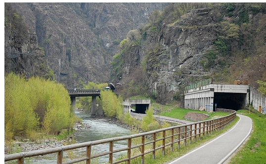
Im Eisacktal zwischen Bozen und Blumau. Die ehemalige Trasse der Brennerbahn wird vielerorts als Radweg genutzt. Foto: Hermann Hammer 2010, https://commons.wikimedia.org
